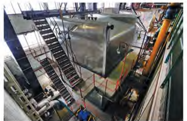
После модернизации водогрейный котёл увеличил энергоэффективность на 15%
